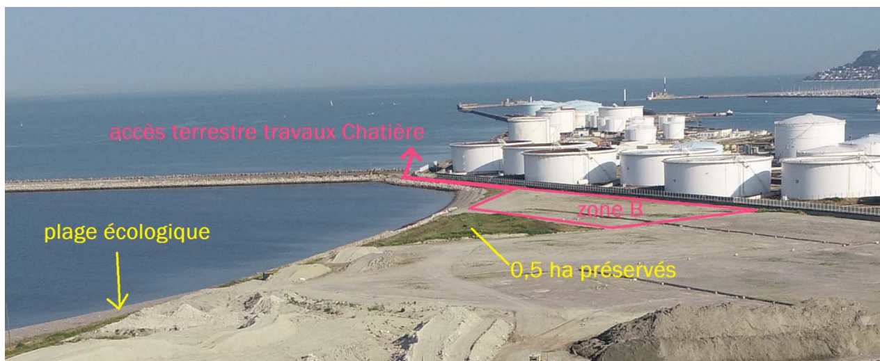
Figure 82 : Travaux en cours en Octobre 2021 sur la « zone B » (photo : SBF – EUCLYD)
