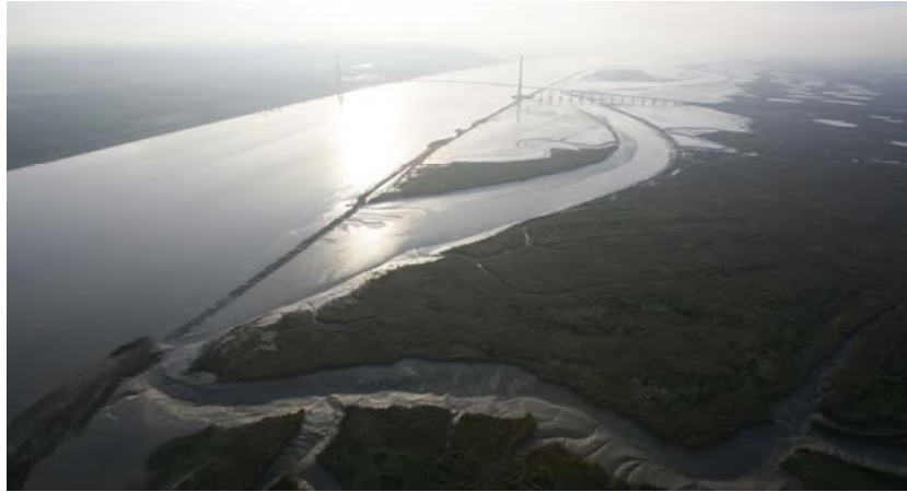
Figure 239 : Vue du chenal environnemental peu après sa construction (2005)
