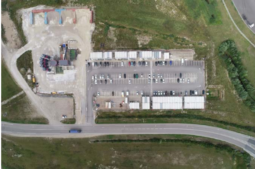
Figure 50 : Vues de la base-vie sur la zone "E" prévue pour le chantier
