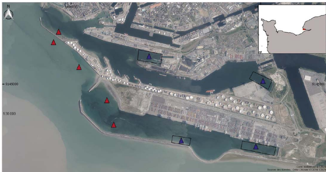
Figure 155 : Proposition de plan d'échantillonnage des habitats et des peuplements benthiques au sein et aux abords de la chatière pour le suivi BACI
