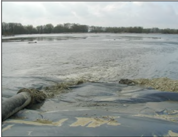
Figure 57 : Illustration d'un refoulement hydraulique par conduites
