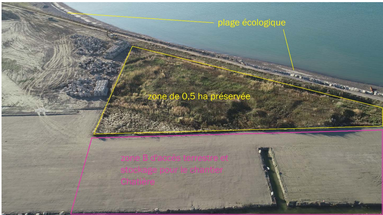
Figure 83 : Travaux en cours en Novembre 2021 sur la « zone B » (photo : SBF – EUCLYD)
